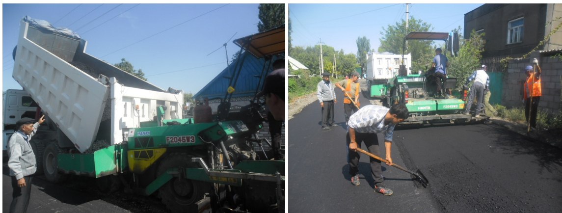
Рис.1. Процесс разгрузки и укладки асфальтобетонной смеси на экспериментальный участок
