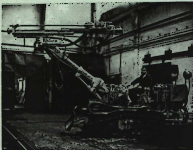
Рисунок 6 – Первый серийный образец бурового агрегата УБШ-215 на гусеничном ходу
