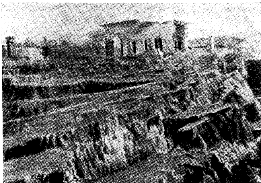
Фиг. 5-8. Бихар, 1934 г. Ступенчатые перекосы грунта, ранее имевшего горизонтальную поверхность; берег озера у Мотихари. (Правительственный отчет.)
