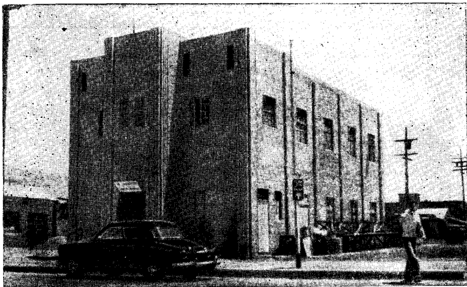
Фиг. 8-4. Неповрежденное здание из бетона в Техачапи (Калифорния); 21 июля 1952 г. (Фото Ф. Е. Лернера.)
