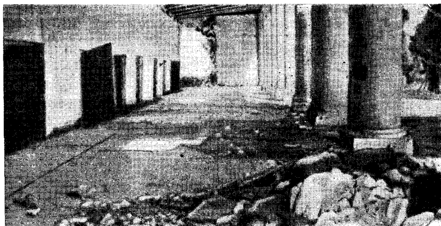
Фиг. 5-7. Пояс просадок. Бихар, 1934 г. Центральная часть дома осела так, что нижняя половина дверей оказалась под полом. (Правительственный отчет.)
