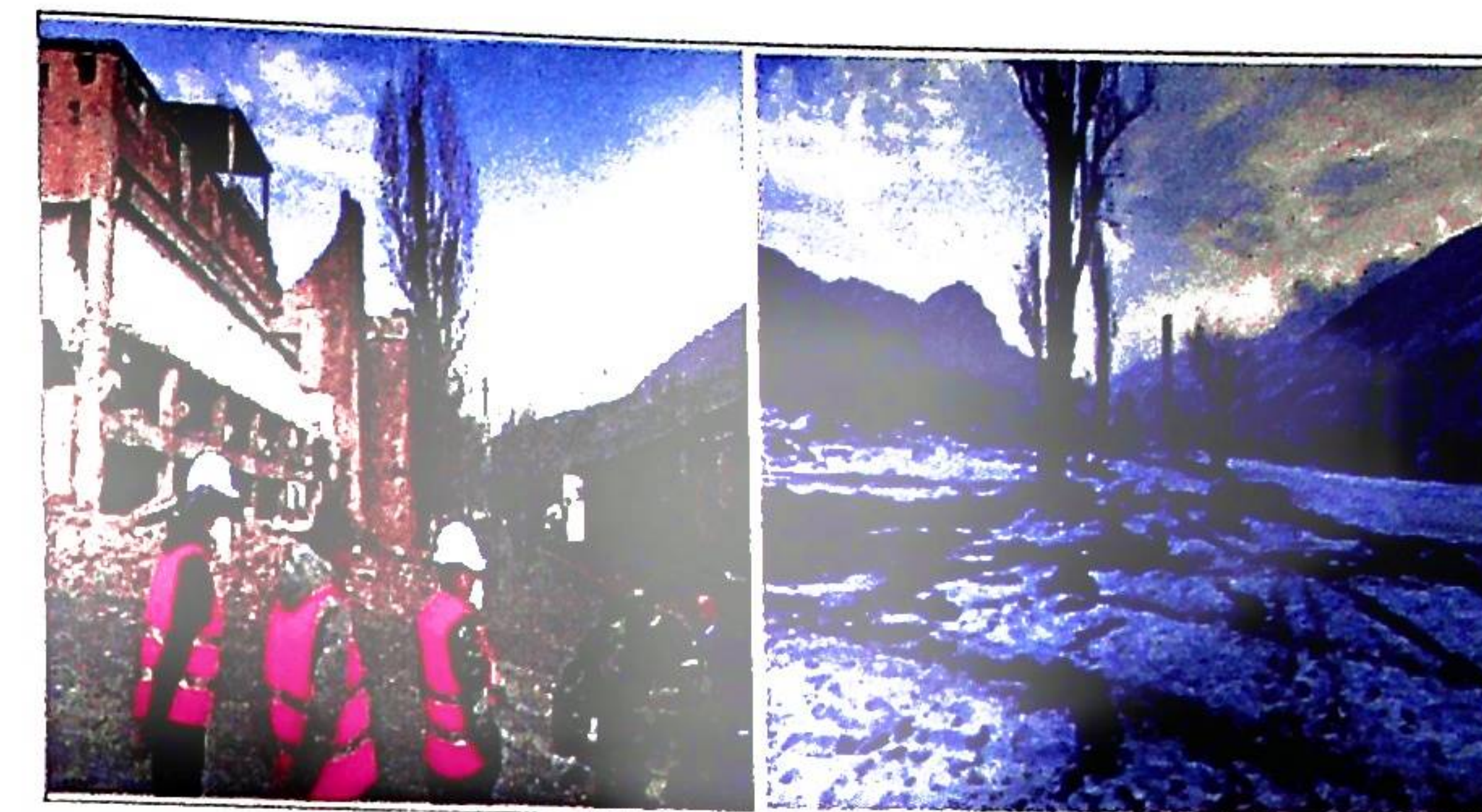
Рекультивационные работы в местности Мин-Куш
