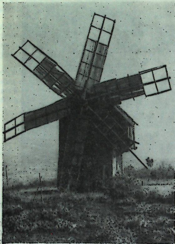
Рис. 5. Столбовая ветряная мельница из с. Чукулены Ниспоренского района МССР.
