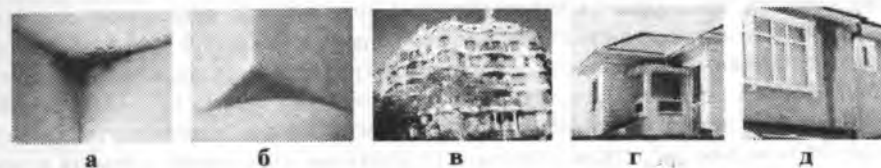
Рис. 8. Вид плесени (а), способы борьбы с тепловыми мостами (б и в), виды тепловых мостов: конструктивных и архитектурных (г), эксплуатационных (д)
