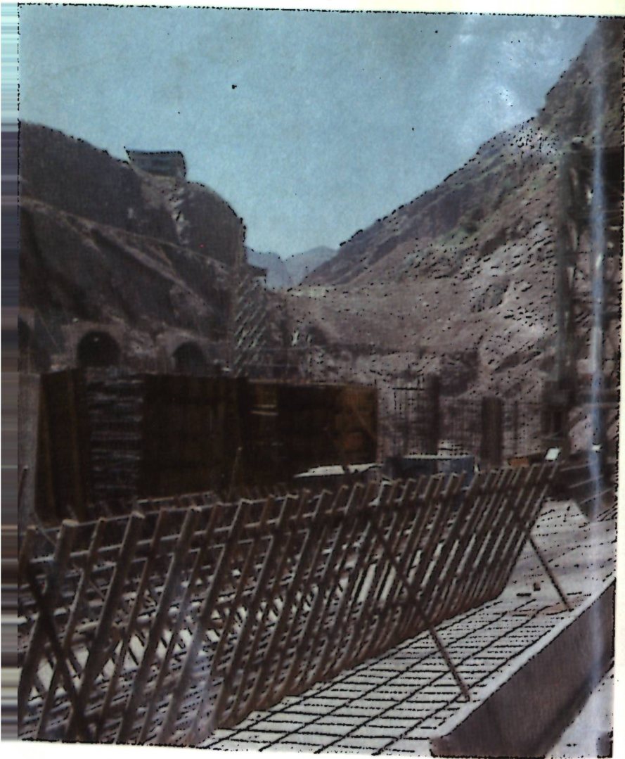
Нурек. Строится плотина
