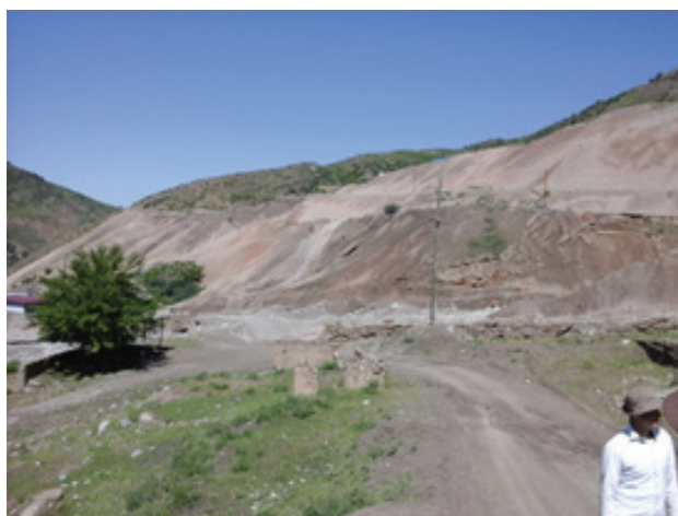
с) Вид отвала с востока
