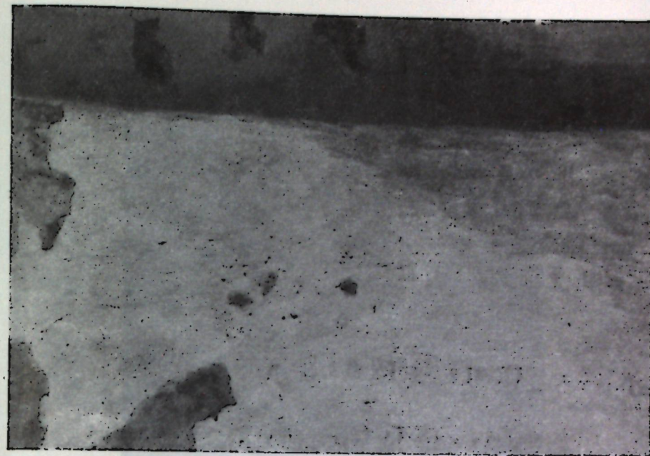
Слой штукатурки и известковой побелки поверх фресковой росписи на северном склоне западной подпружной арки
