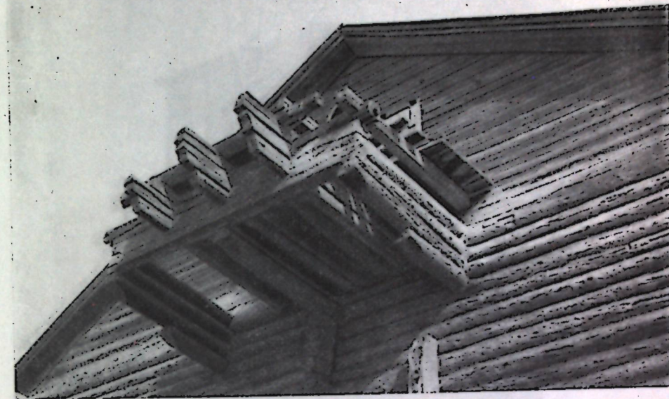
Балкон — верхняя площадка погрузочной лестницы амбара для хранения соли близ г. Усоля Молотовской обл. Фото И. В. Маковецкого.
