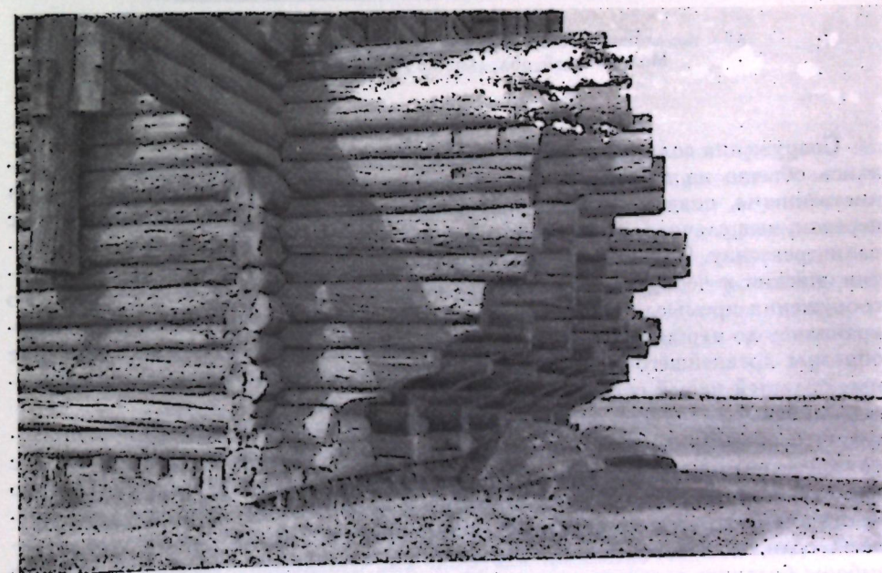
Консоли, поддерживающие галерею соляного амбара для хранения соли близ г. Усоля Молотовской обл. Фото И. В. Маковецкого.
