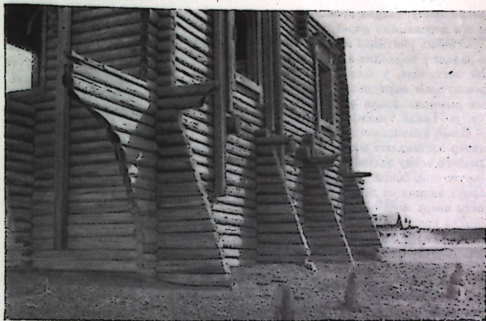
Контрфорсы башни соляного колодца близ г. Усолья Молотовской обл. Фото И. В. Маковецкого.
