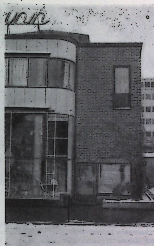
17. Фрагмент фасада магазина в городе Лахти
