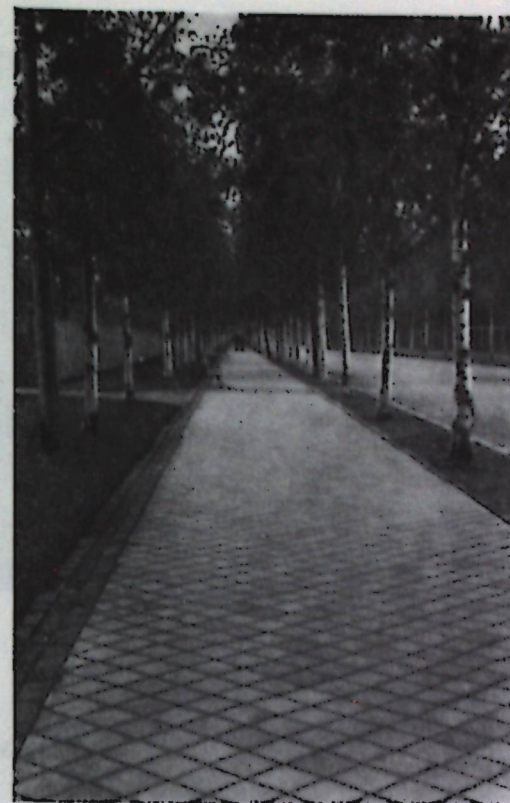
15. Оформление бетонными плитками парковых дорожек
