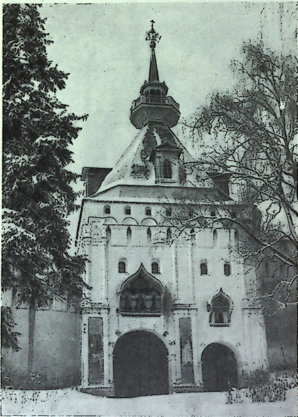
Рис. 4. Красные ворота монастыря (снимок Музея архитектуры Академии строительства и архитектуры СССР)
