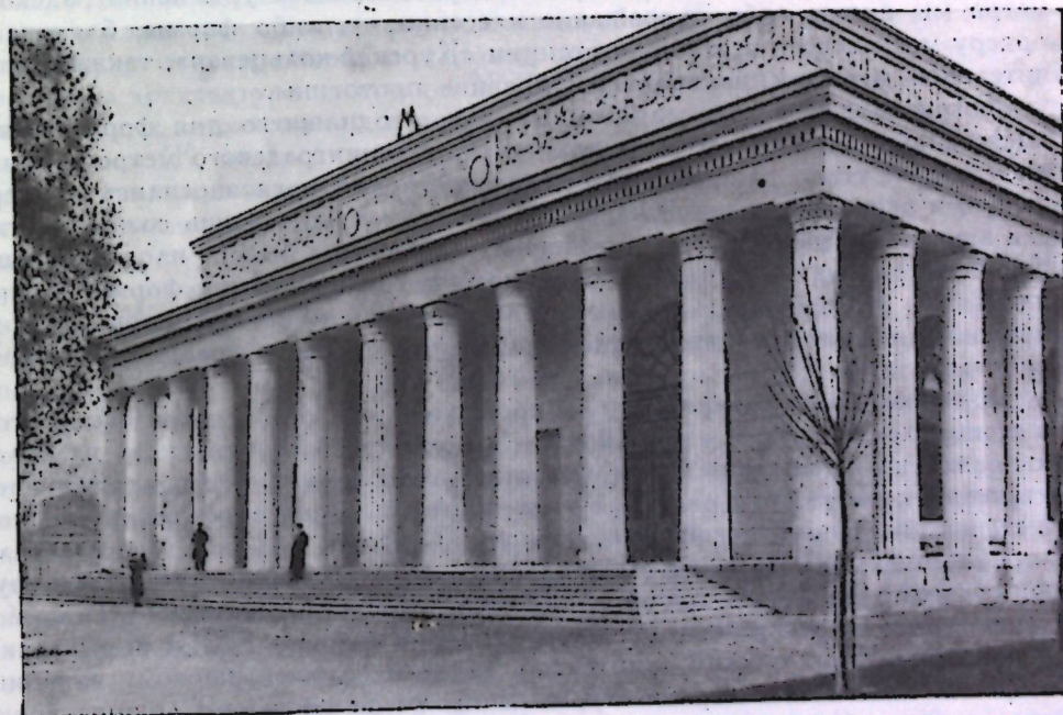
Рис. 2. Наземный вестибюль станции «Кировский завод»
