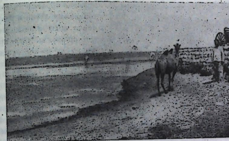
Фиг. 23. Земляная плотина, построенная местным населением на одном из протоков р. Уила для орошения лугов.
