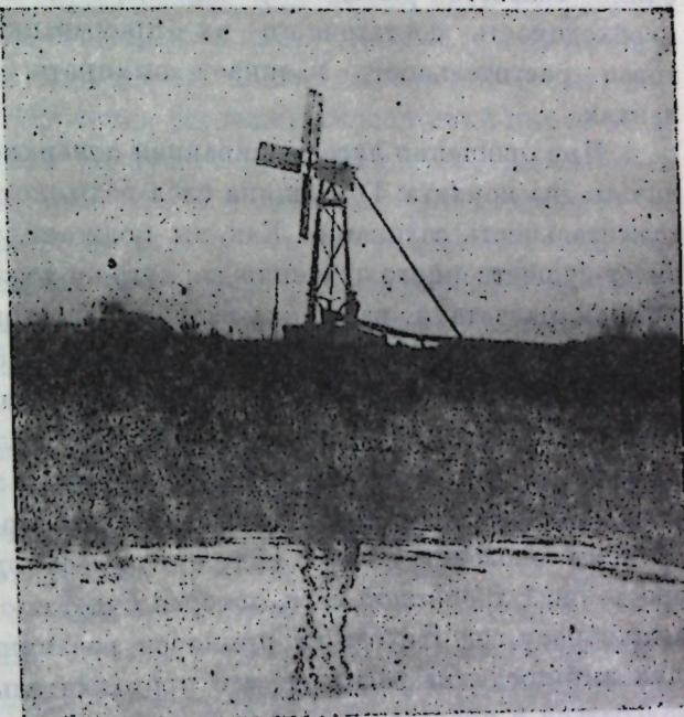
Фиг. 25 Ветряной двигатель для подъема воды из реки Урала.
