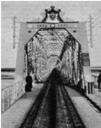
Мост через Амударью
