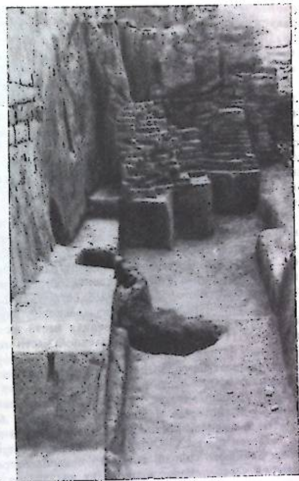
Рис. 46. Городская стена Орен-кала. Кладка трех строительных периодов.
