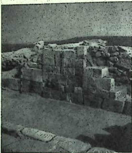
Рис. 18. Бакинское городище. Кладка 4. Строительный шов отделяет часть ее в технике «квадровой кладки».
