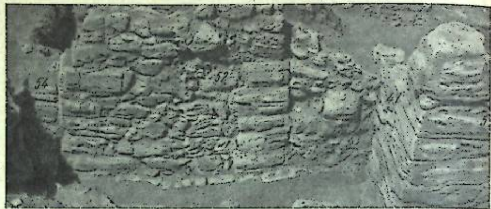
Рис. 58. Вид стен 54, 52, 47 и 5 с востока
