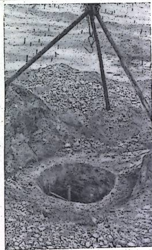
Рис. 47. Устья шахт а — плита, соответствующая устью шахт; б — устье шахты № 3 и приспособление для подъема мела
