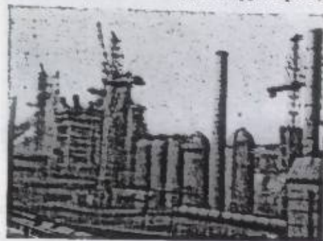
Рис. 1. Листовые конструкции доменного цеха.
