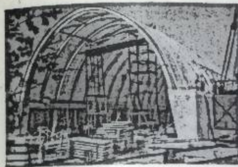
Рис. 2. Общий вид светопрозрачного покрытия бассейна в г. Пушкино.
