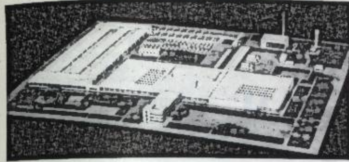
Проект мясо-птицекombината (общий вид): 1 — зона основного производства; 2 — зона подсобных сооружений; 3 — зона предубойного содержания скота и птицы.
