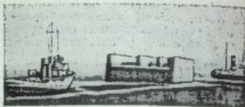
Рис. 5. Буксировка здания приливной электростанции к месту установки (проект).
