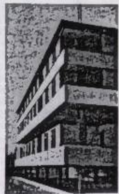
Рис. 2. Стро-во жилого дома (подъем 2-го этажа).
