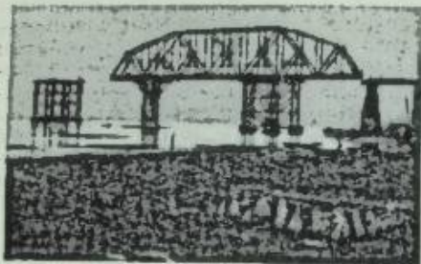
Рис. 3. Продольная навивка пролетного строения.
