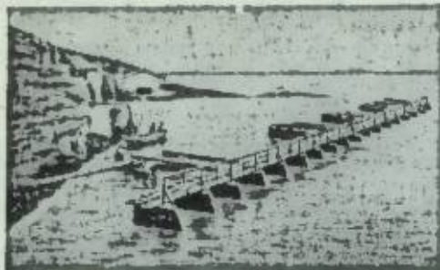
Рис. 2. Направляющая система щитов-понтон на р. Аму-Дарье.
