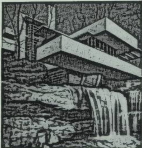
Рис. 1. Жилой дом «Водопад». Общий вид (Ф. Л. Райт).
