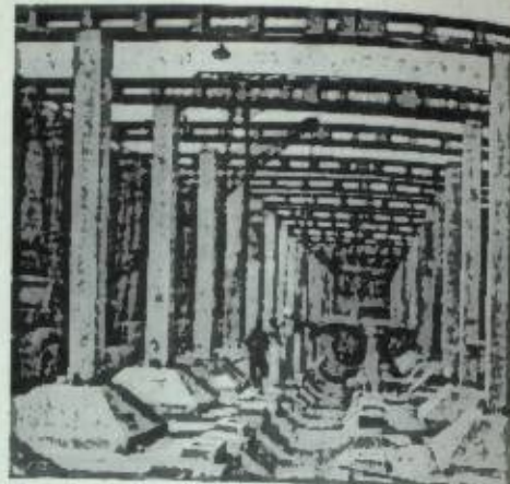
Рис. 5. Монтаж железобетонных конструкций станции метрополитена.
