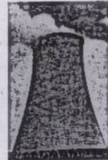
Рис. 2. Градирня гиперболич. формы с башней из монолитного железобетона.
