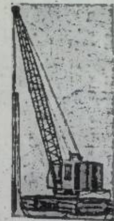
Рис. 1. Гидровибратор тяжелого типа, установленный на самоходном гусеничном кране.
