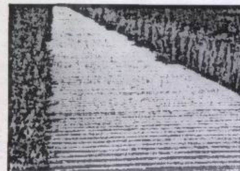
Рис. 3. Ребристое бетонное покрытие.
