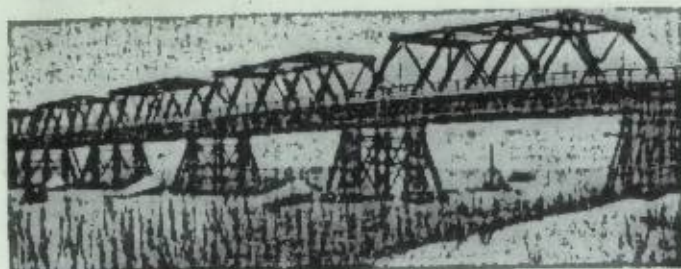
Рис. 4. Временный деревянный автодорожный мост. Пролетные строения с садовой понизу.
