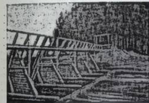
Рис. 2. Разборчатая плотина с поворотными деревянными треугольными фермами.
