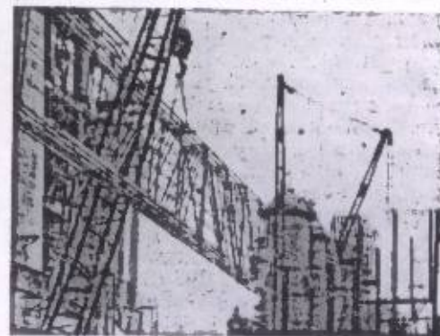
Монтаж арматурных конструкций промышленного сооружения.
