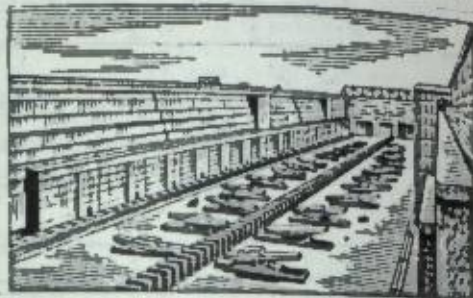
Рис. 2. Камера дока, оборудованная металлич. кильблоками.
