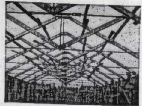
Рис. 2. Треугольные брусовые фермы ЦНИИСК, l=12 м.
