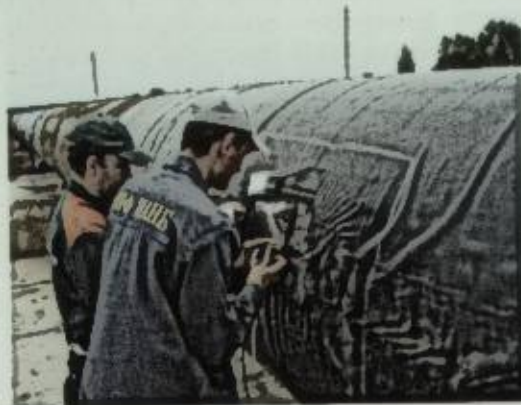
К ст. Институт прикладной физики: сотрудники ИПФ проводят диагностику на действующем трубопроводе
