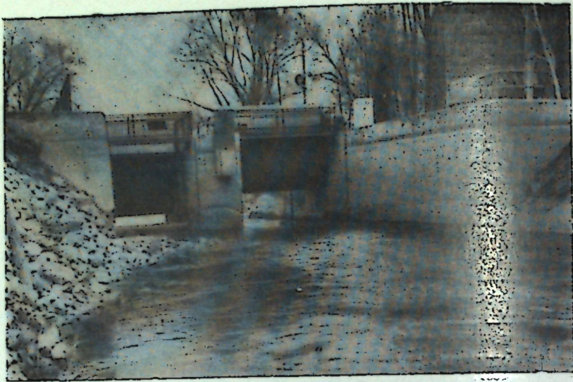
Автоматизированное головное сооружение Ат-Башинского магистрального канала.
