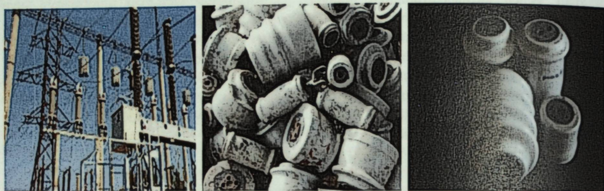
4-сүрөт. Жогорку чыңалуу дагы жаны жана иштетилген изоляторлор
