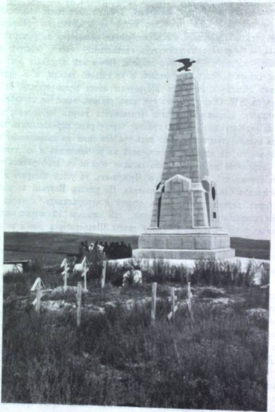
Фиг. 18. Памятникъ въ стан. Казанско-Богородской, давшій сквозную трещину по швамъ кладки, въ направленіи NW—SO, и незначительный сколъ камня на NW сторонѣ трещины. Если трещины, то онѣ круто падаютъ на NW и N; саманная обмазка (туземная штукатурка) падала туда же; высокіе дувалы (напр., въ караванъ-сараѣ Султанъ-куль—
