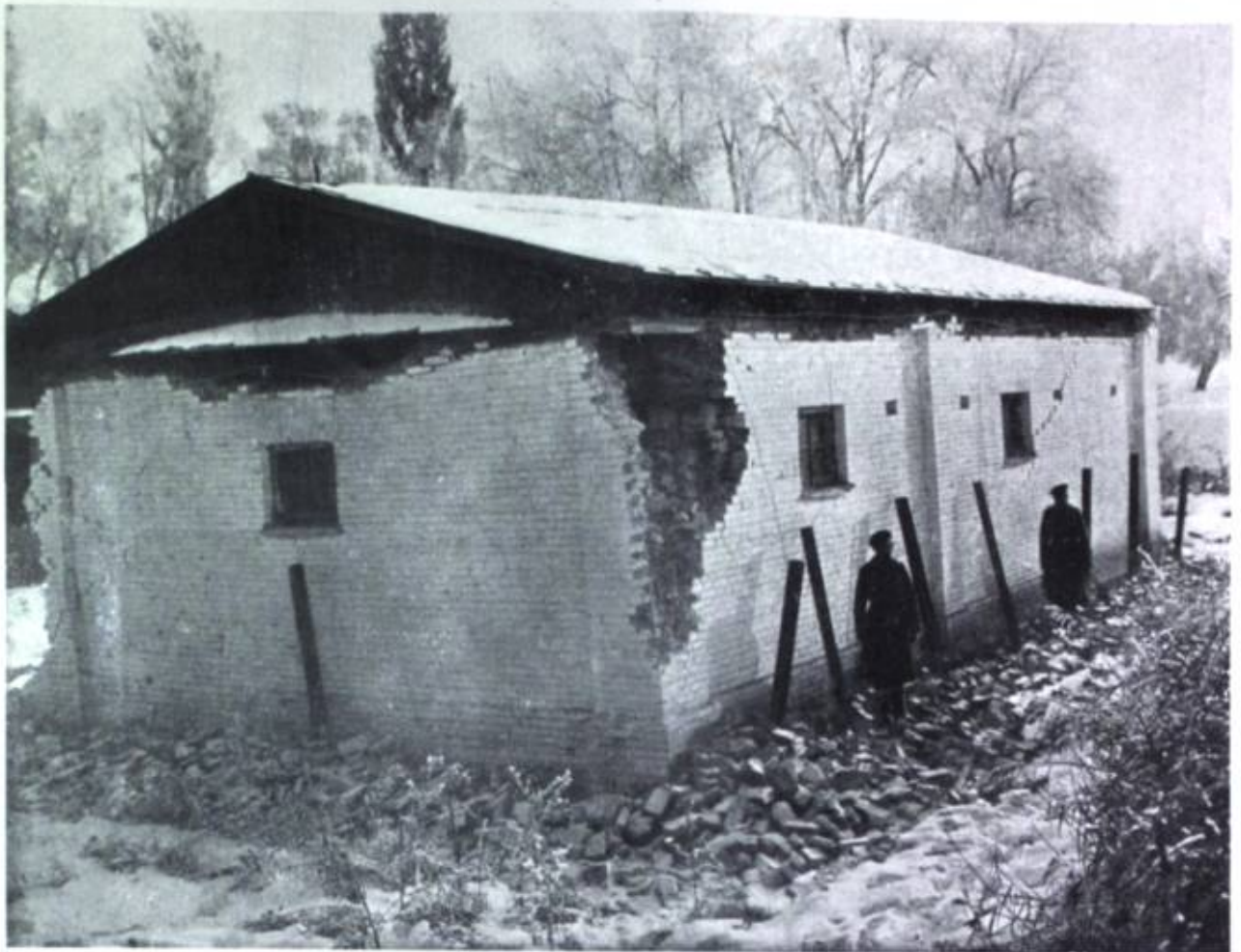
Пороховой погребъ, въ крѣпости. Вѣрный. Паденіе юго-восточнаго угла.
