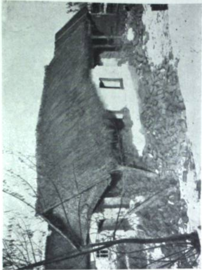
Домъ Жданова, Клеверные участки, Вѣрный. Падение угла на SW.
