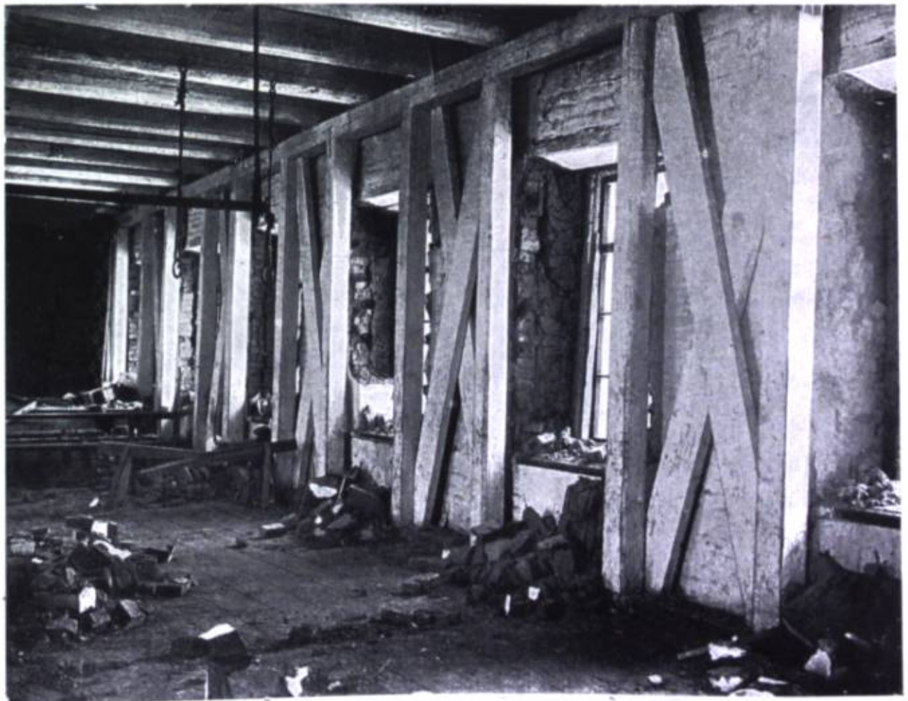
Артиллерійскія казармы. Вѣрный. Примѣръ вліянія внутреннихъ подпорныхъ каркасовъ.
