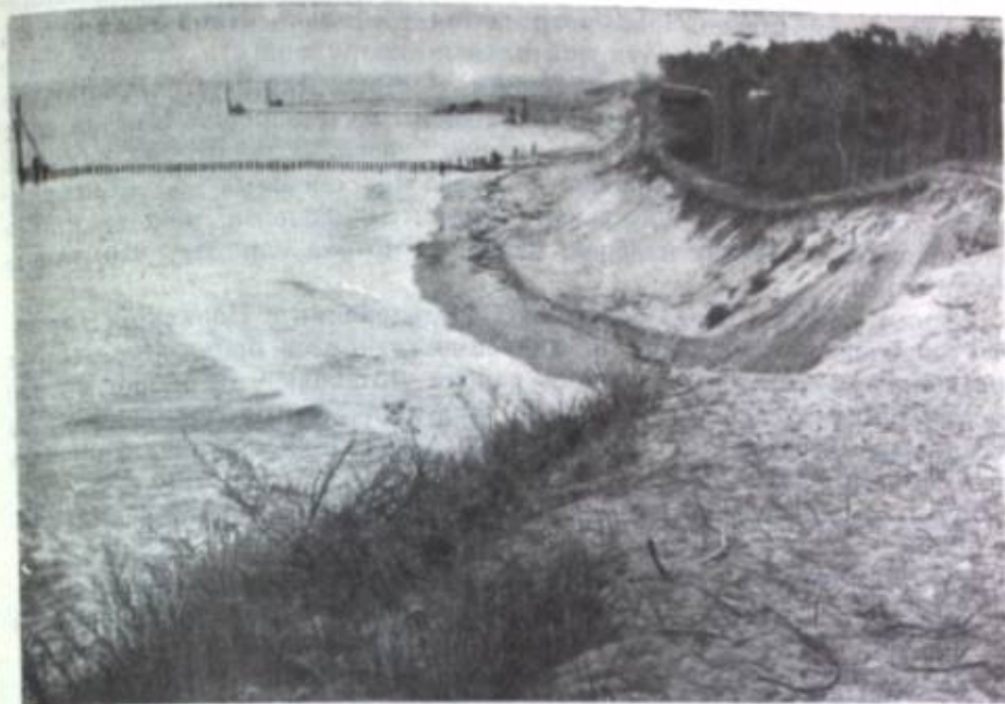
Рис. 2. Строительство ажурных свайных бун на размываемом участке польского побережья
