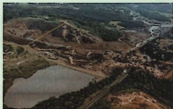
Фото. Выброс хвостов обогащения руды после разрушения дамбы хвостохранилища
