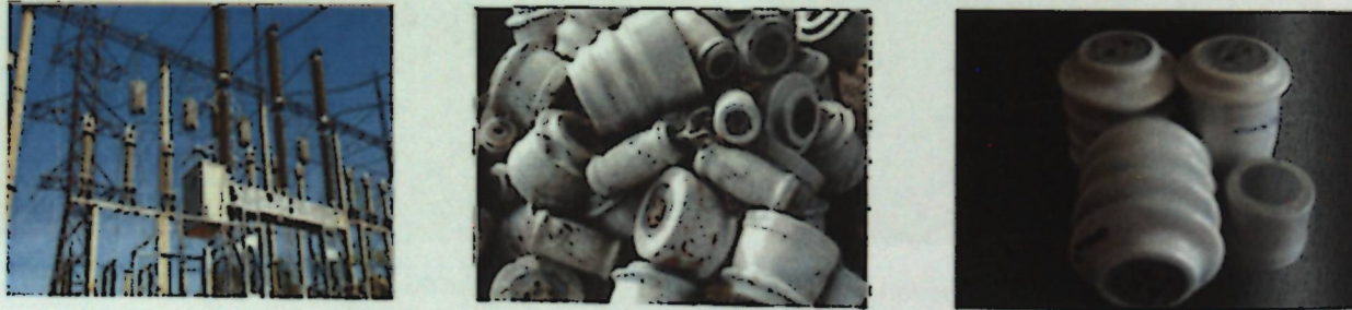
Рис. ЛЭП на РЭС, отработанные высоковольтные фарфоровые изоляторы и новые полученные ВФК на базе местного сырья
