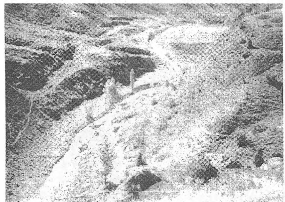
Рис. 6. Оползень в нижних участках хвостохранилища
