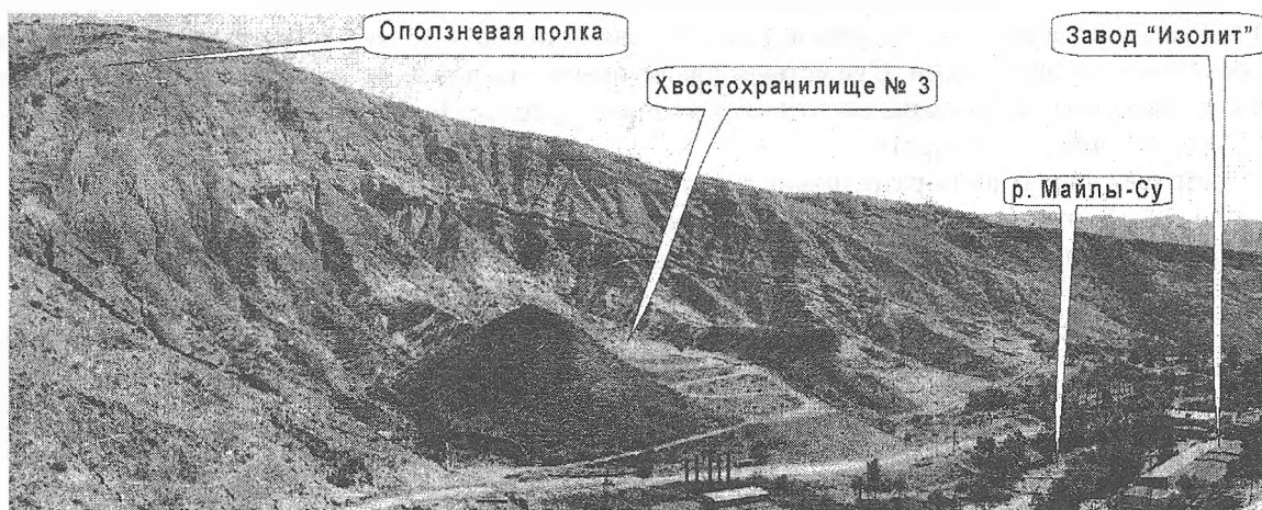
Рис. 2. Горнотехнические объекты в оползнеопасной зоне
