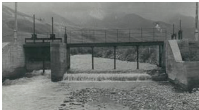
Фото 2(а, б). Водозаборные сооружения донно-решетчатого типа на реках Каракол и Сокулук
