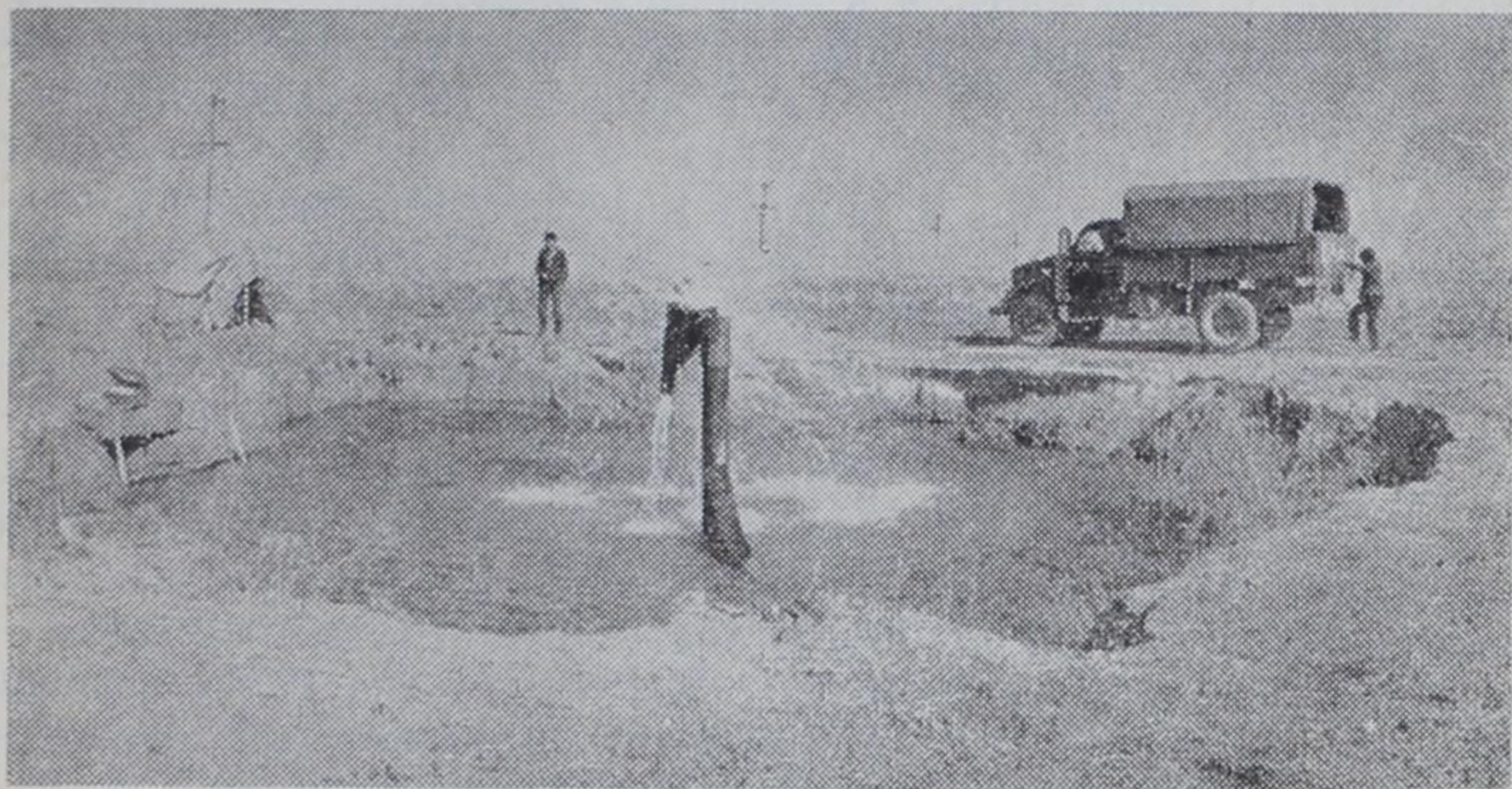
Рис. 1. Самоизливающаяся скважина из аллювиально-пролювиальных отложений. Расход 40 л/сек. Напор + 3 м. Фото Г. Г. Ошлакова
