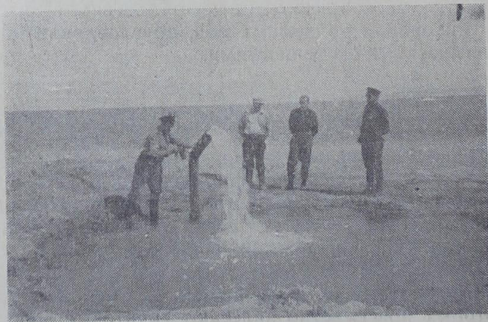
Рис. 14. Скважина, вскрывающая напорные воды конуса выноса у села Джарбулак. Расход самоизлива 50 л/сек.
