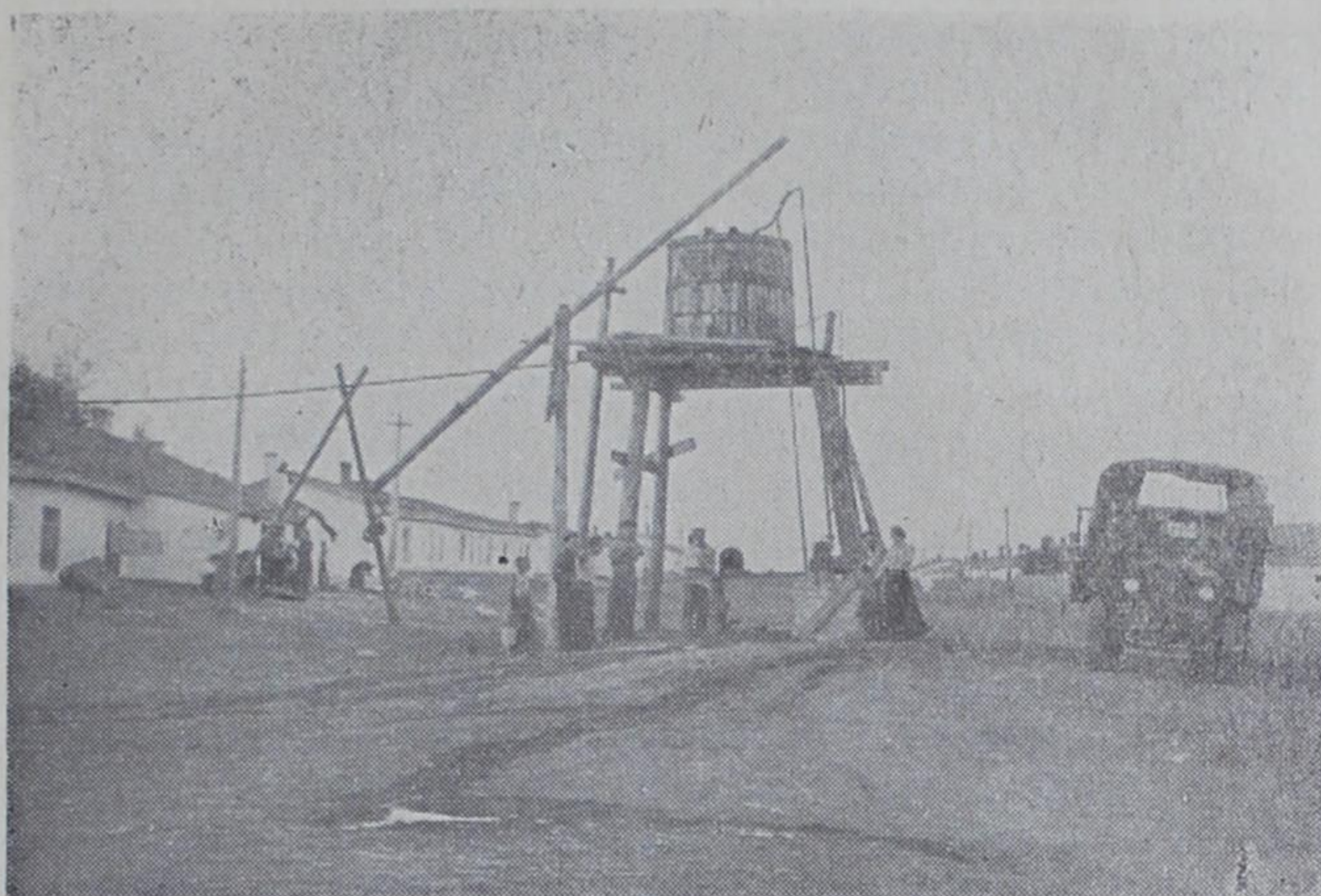
Рис. 39. Колодец у пос. Шахты (вода поступает из эоценовых песчаных отложений). Фото А. Солнцева.
