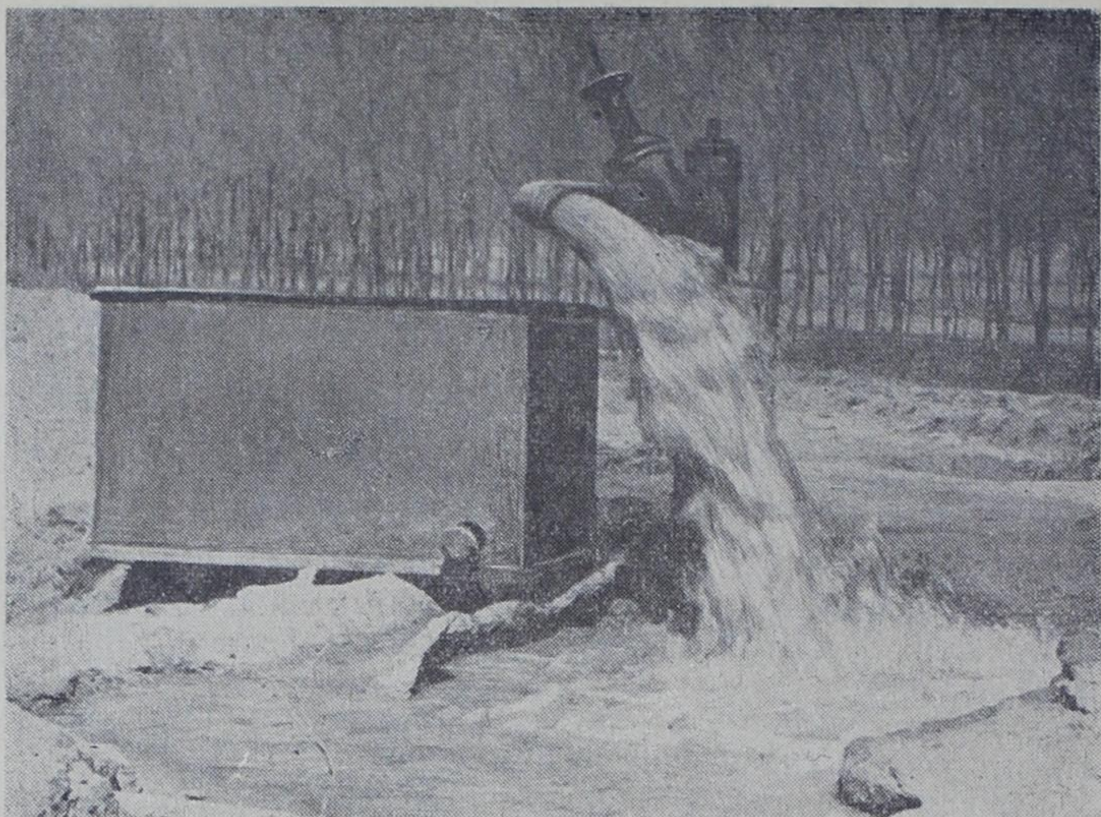
Рис. 55. Скважина, каптирующая напорные воды четвертичных отложений предгорной равнины Зайлийского Алатау и дающая при самоизливе 50 л/сек (с. Покровка).
