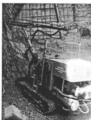
Рис. 2. Буровая установка типа БМ-18 на строительстве ГЭС Камбарата 2.
