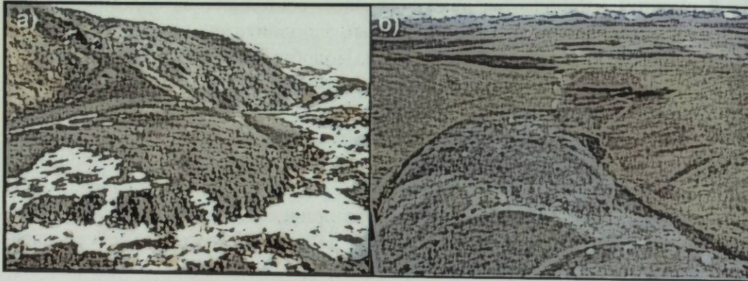
Рис. 59. Оползневые явления на отвалах: а) оползень-оплывина на отвале в бассейне р. Кичи Сары-Тор, ниже Юго-Западного карьера, частично перекрывший русло этого ручья (фото 12 октября 2012 г); б) оползающая масса отвалов, движущаяся по долине р. Кичи Сарытор в долину р. Кумтор по состоянию на август 2014 г.
