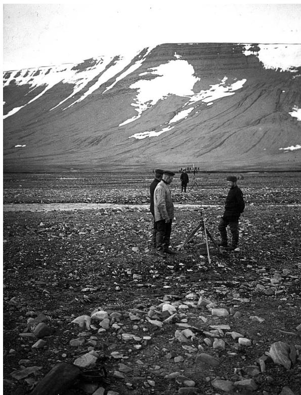
1655. Рабочий момент четвёртого сезона экспедиции — измерение базиса у склона горы Гельвальд на восточном берегу о. Западный Шпицберген. На переднем плане — укрепленный на треноге геодезический прибор, применяемый для измерения расстояния между точками координат географических объектов; рядом — группа из трёх человек (справа А.С. Васильев, слева двое рабочих).
