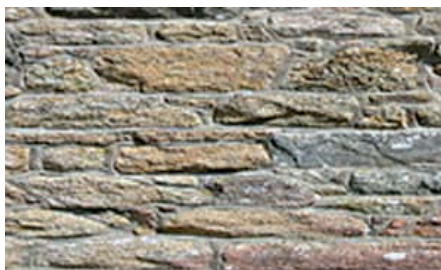
а) кладка из бутовых (карьерных) камней; б) кладка из натуральных камней
