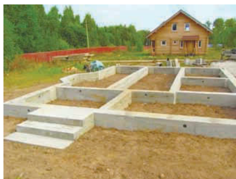
а) Фундамент у древних строений б) Фундамент современного дома
