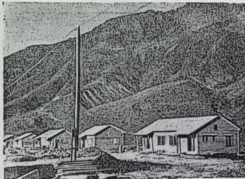
Рис. 38. Город Ташкумыр. Строительство жилых домов на шахте «Северная».
