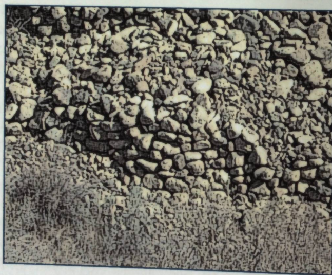
Фото 274-2. Подпорная стенка в промывочной траншее россыпи Кара-Тюбе (фото Н.Т. Пака)
