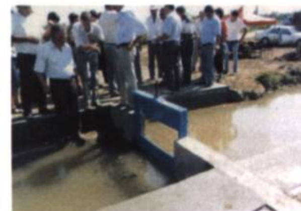
Фото 3. Водомерное сооружение типа «Прямоугольный насадок» на Р-8 системы ЗБЧК
