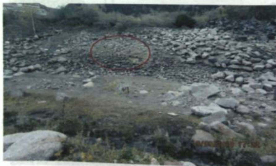
Фото 4. Скопление радиоактивного отхода у подножия х/х №1 (ручеек в 30 м впадает в р.Кичи-Кемин).
