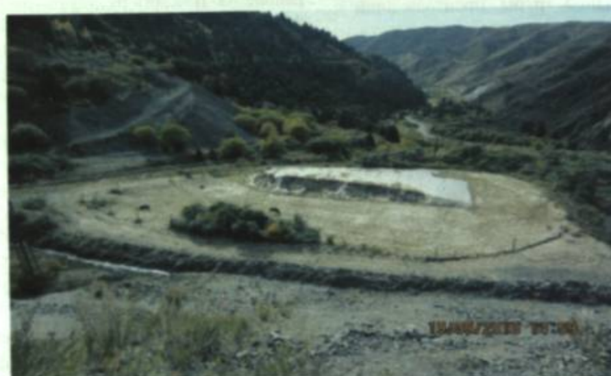
Фото 3. Временное захоронение радиоактивной руды с гамма-активностью свыше 800 мкр/час на поверхности х/х №1.
