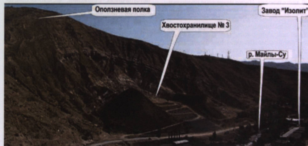
Рис. 1. Горнотехнические объекты в оползнеопасной зоне
