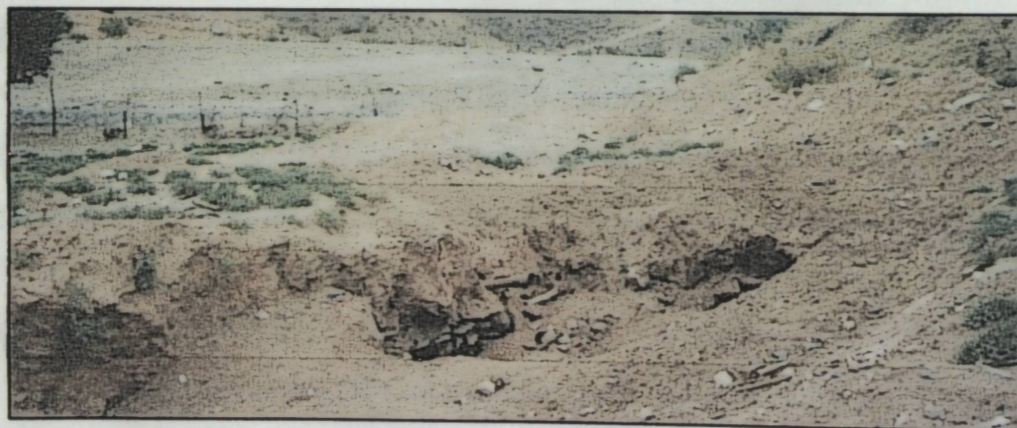
Рис.2. Раскопки на хвостохранилище №6 в г. Майлуу-Суу, хорошо видны остатки радиационно-загрязненного оборудования, утилизированного на площадке захоронения
