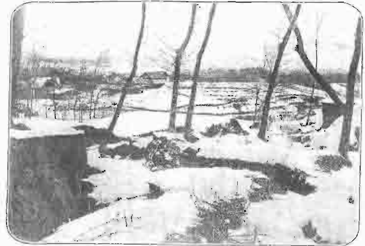
Трещины, образовавшіяся на поверхности земли послѣ землетрясенія.
