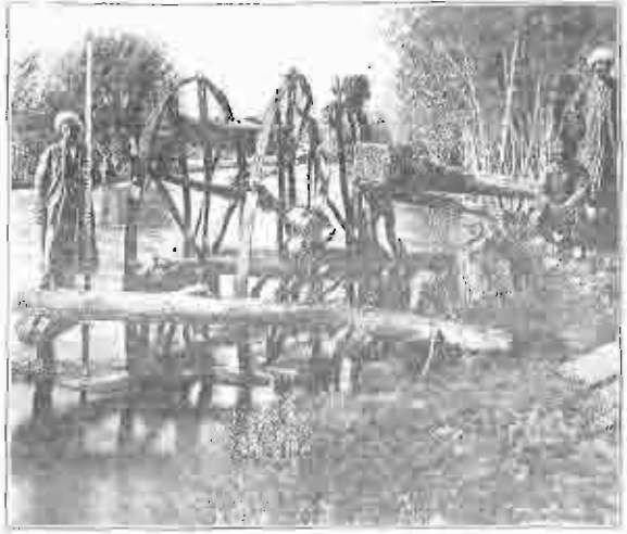
Первообытный и наиболее распространенный способ подъема воды. Чугиръ устанавливается на быстромъ течении рѣки или, какъ въ данномъ случаѣ, искусственного канала: колесо подвешено кверху, лопастями крутится и вода захватывается въ лопастяхъ, поднимаются наверхъ, и въ жерновъ идетъ на берегъ въ арыкъ.
