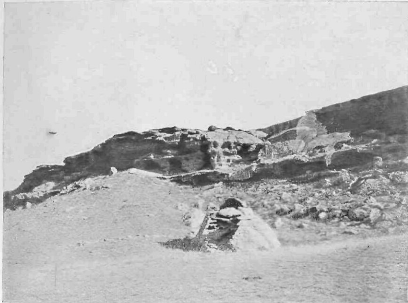
Разрушеніе края плато.
