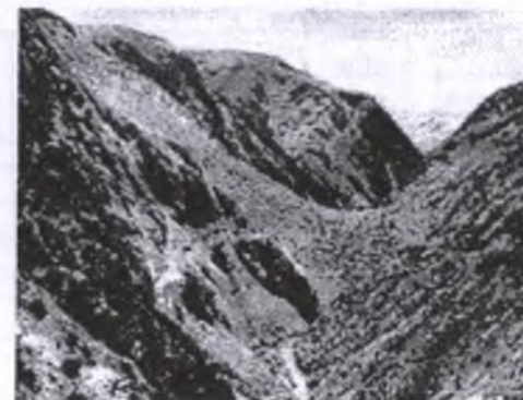
Рис. 4. Взрыво-набросная плотина на р. Уч-Терек. Высота плотины — 47 м. Вид с нижнего бьефа
