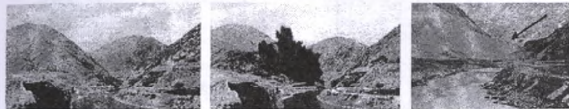
Рис. 5. Двойной взрыв, произведенный при строительстве ГЭС «Камбар-Ата-2»
