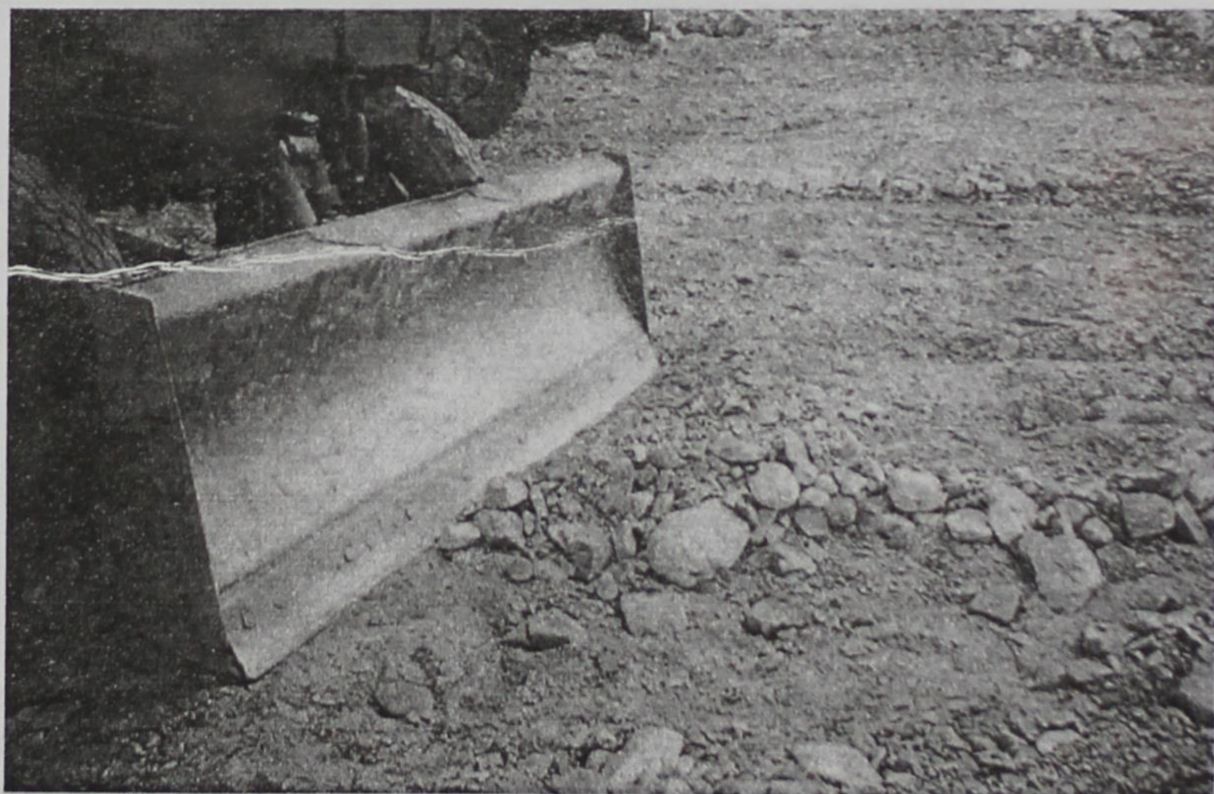
Рис.2. Расчистка дорог после обрушения предгорных склонов
