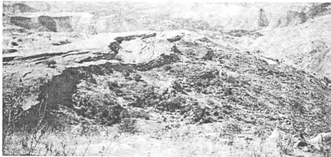
Рис. 3. Верхняя часть оползня "Тектоник": зона формирования оползневых блоков.
