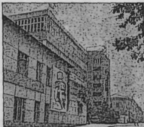
Здание головного предприятия обувного производственного объединения.
