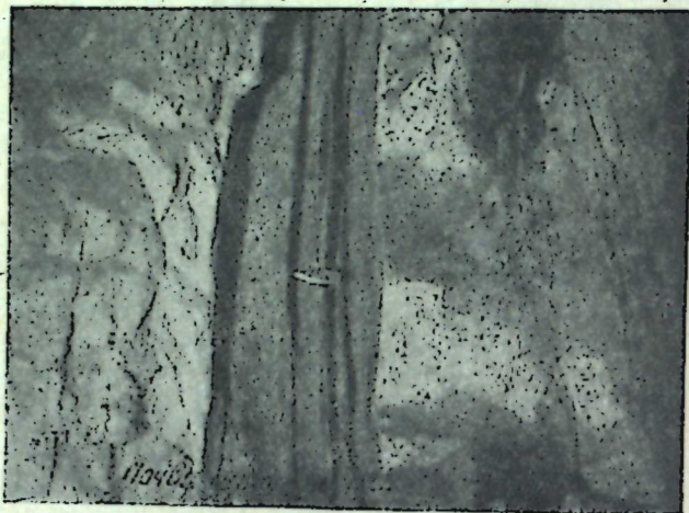
Фиг. 11. Трещина, выполненная разрушенным и измененным щелочным базальтом. Южная стенка «Первомайского» штрека, шт. № 4. Снимок Л. П. Горина.
