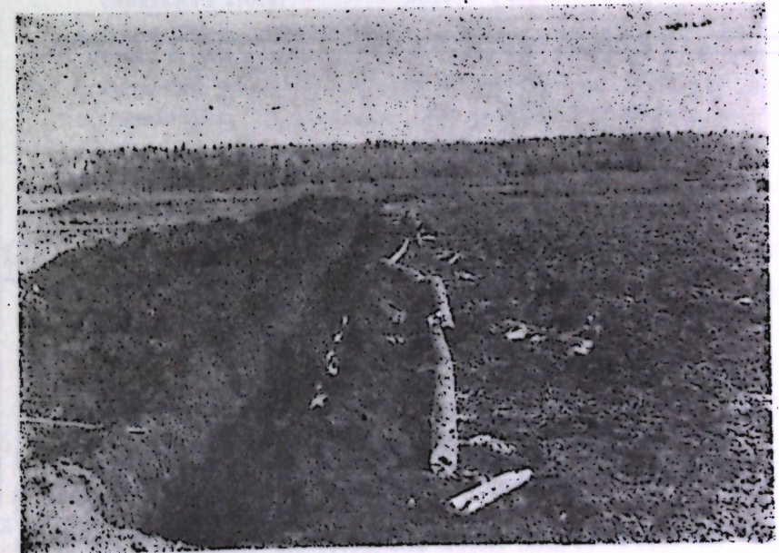
Рис. 1. Укладка деревянных дрен.
