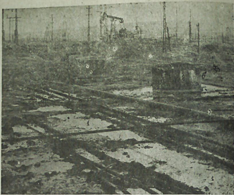
Рис. 2. 1 — залитые нефтяными отходами участки; 2 — пожарные чаны: а — железобетонные; б — металлические.
